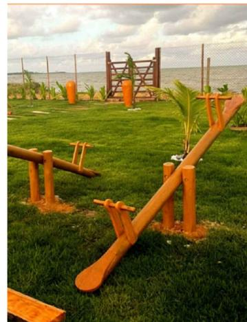
Gangorra construída com madeira de Eucalipto e Pinus autoclavado.
