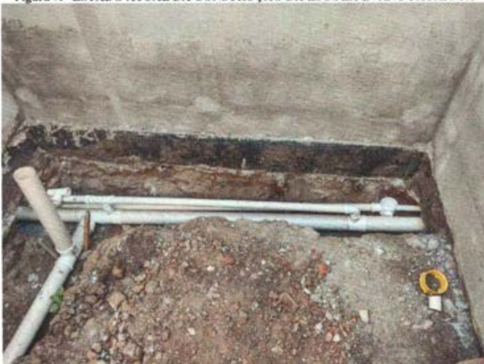
Figura 9. ESTADO ATUAL DA CONSTRUÇÃO DA ESCOLA EVANY PATRIOTA
