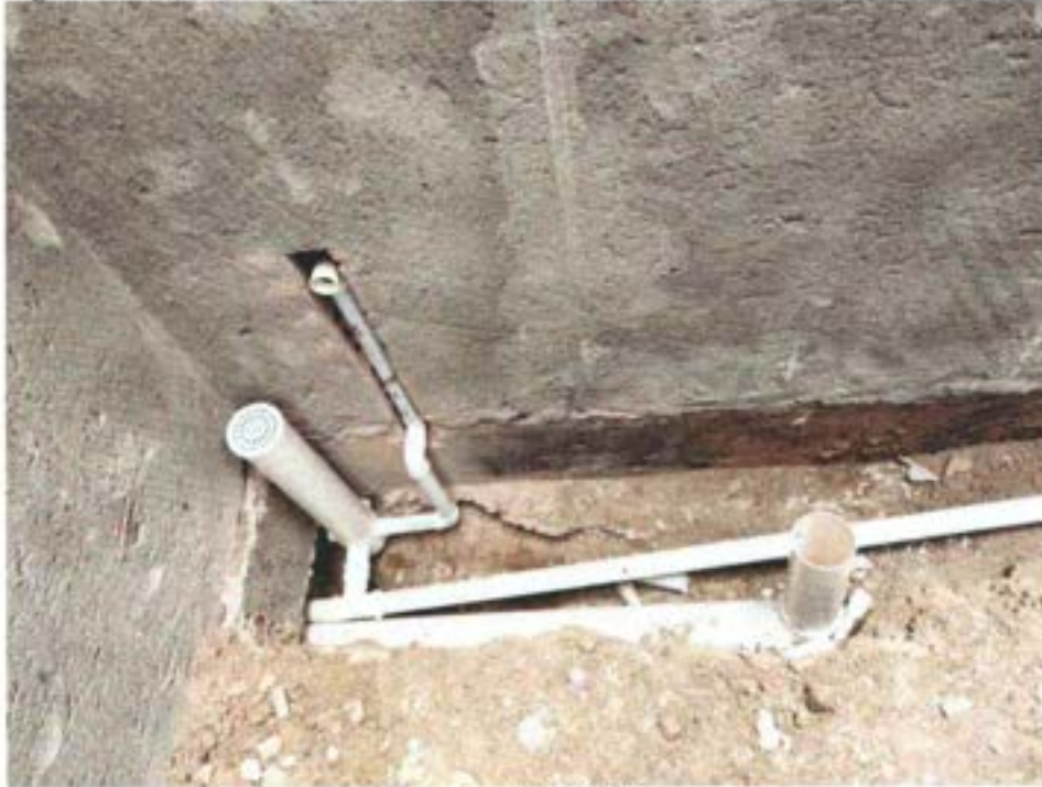
Figura 12. ESTADO ATUAL DA CONSTRUÇÃO DA ESCOLA EVANY PATRIOTA
