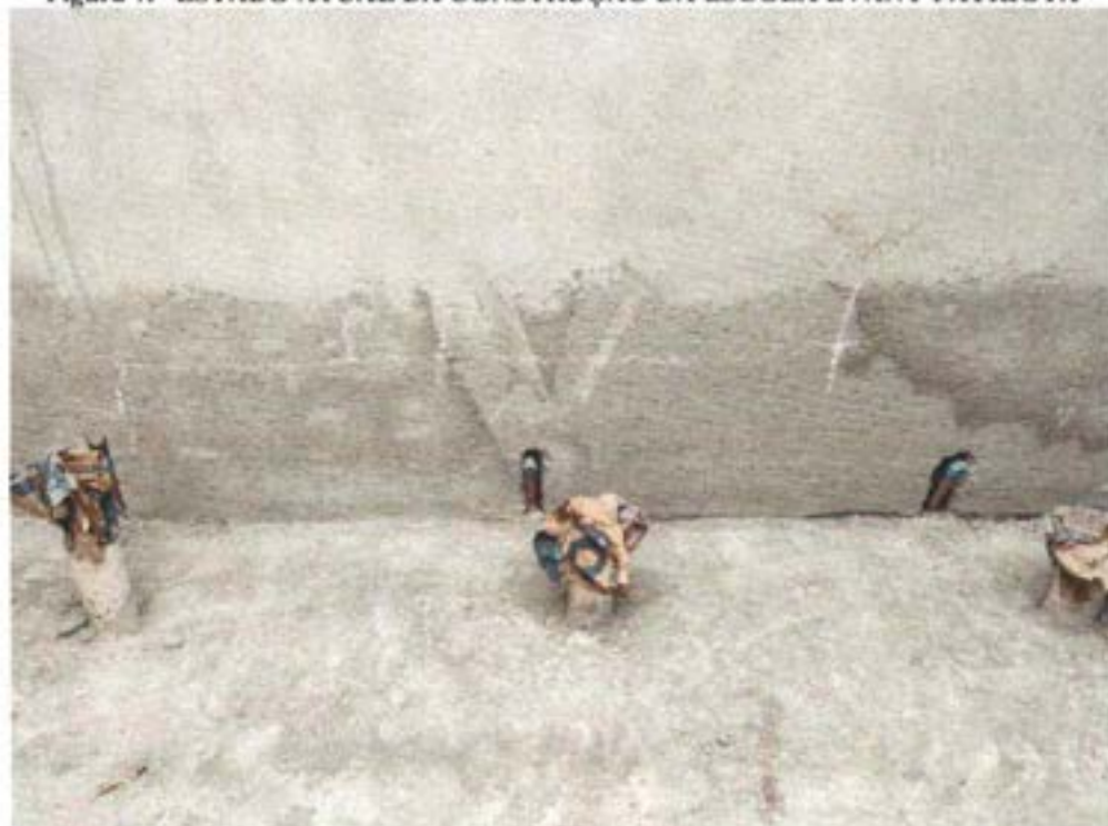
Figura 7. ESTADO ATUAL DA CONSTRUÇÃO DA ESCOLA EVANY PATRIOTA
