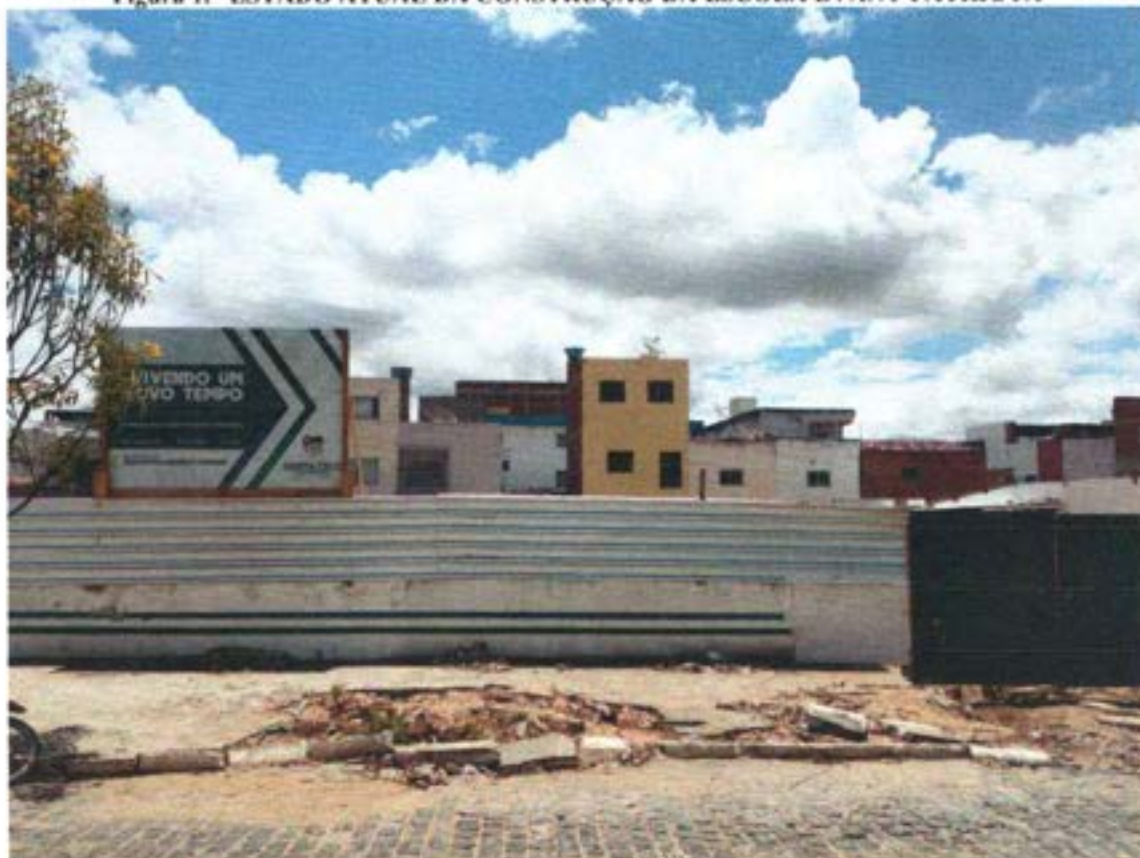
Figura 1. ESTADO ATUAL DA CONSTRUÇÃO DA ESCOLA EVANY PATRIOTA
