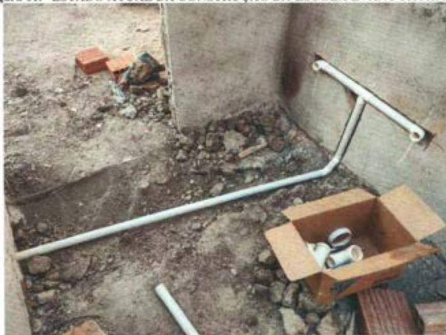
Figura 11. ESTADO ATUAL DA CONSTRUÇÃO DA ESCOLA EVANY PATRIOTA
