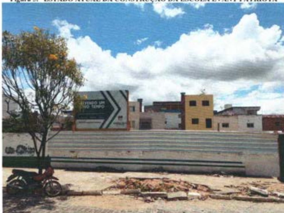
Figura 5. ESTADO ATUAL DA CONSTRUÇÃO DA ESCOLA EVANY PATRIOTA
