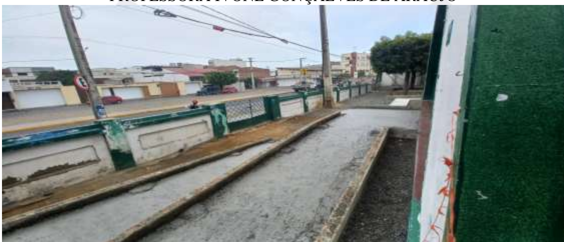
Figura 87. CONSTRUÇÃO DE SALAS DE AULAS NA ESCOLA MUNICIPAL PROFESSORA IVONE GONÇALVES DE ARAÚJO
