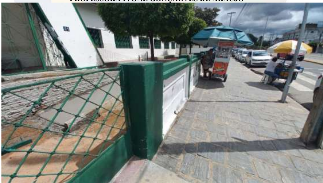
Figura 3. CONSTRUÇÃO DE SALAS DE AULAS NA ESCOLA MUNICIPAL PROFESSORA IVONE GONÇALVES DE ARAÚJO
