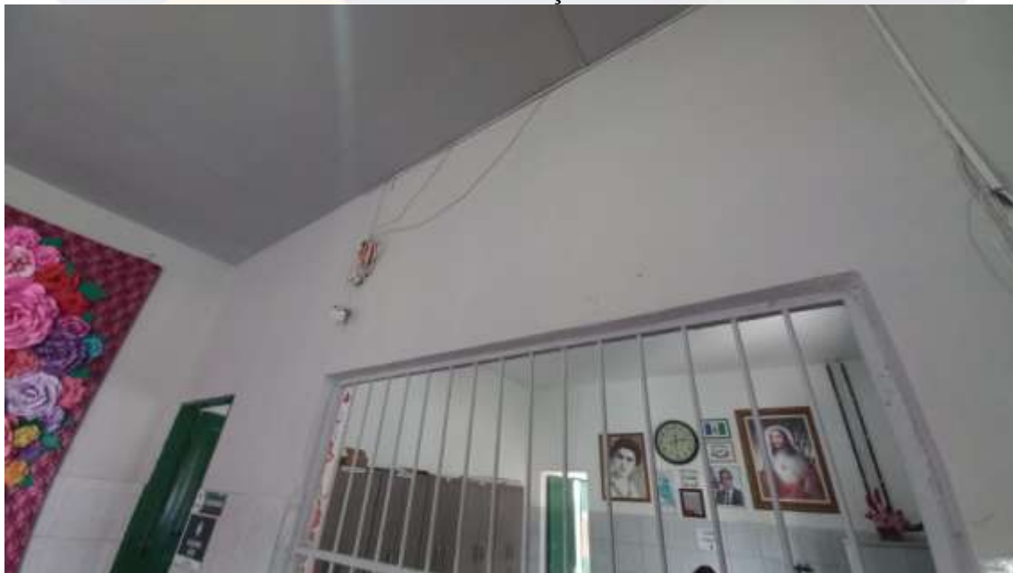
Figura 33. CONSTRUÇÃO DE SALAS DE AULAS NA ESCOLA MUNICIPAL PROFESSORA IVONE GONÇALVES DE ARAÚJO
