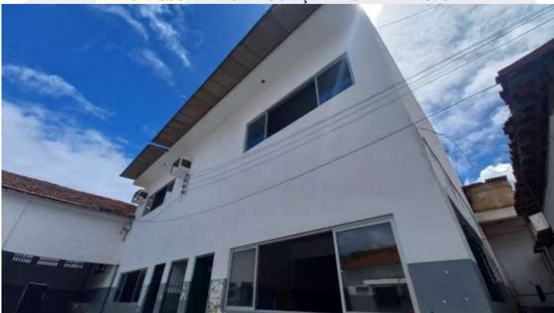
Figura 73. CONSTRUÇÃO DE SALAS DE AULAS NA ESCOLA MUNICIPAL PROFESSORA IVONE GONÇALVES DE ARAÚJO
