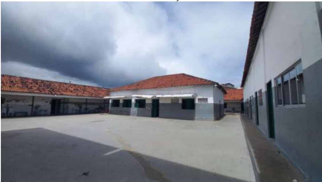
Figura 72. CONSTRUÇÃO DE SALAS DE AULAS NA ESCOLA MUNICIPAL PROFESSORA IVONE GONÇALVES DE ARAÚJO
