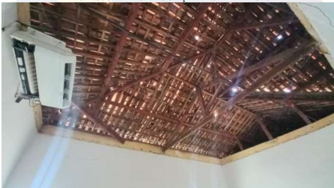
Figura 53. CONSTRUÇÃO DE SALAS DE AULAS NA ESCOLA MUNICIPAL PROFESSORA IVONE GONÇALVES DE ARAÚJO
