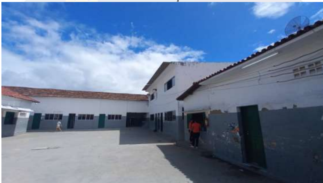
Figura 59. CONSTRUÇÃO DE SALAS DE AULAS NA ESCOLA MUNICIPAL PROFESSORA IVONE GONÇALVES DE ARAÚJO
