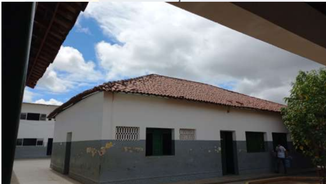
Figura 77. CONSTRUÇÃO DE SALAS DE AULAS NA ESCOLA MUNICIPAL PROFESSORA IVONE GONÇALVES DE ARAÚJO
