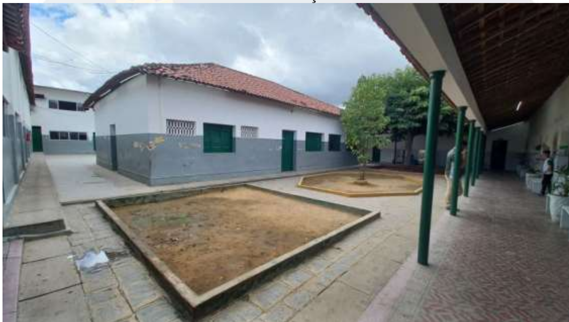
Figura 15. CONSTRUÇÃO DE SALAS DE AULAS NA ESCOLA MUNICIPAL PROFESSORA IVONE GONÇALVES DE ARAÚJO
