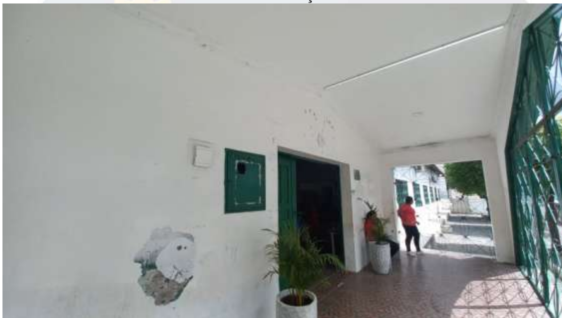
Figura 7. CONSTRUÇÃO DE SALAS DE AULAS NA ESCOLA MUNICIPAL PROFESSORA IVONE GONÇALVES DE ARAÚJO
