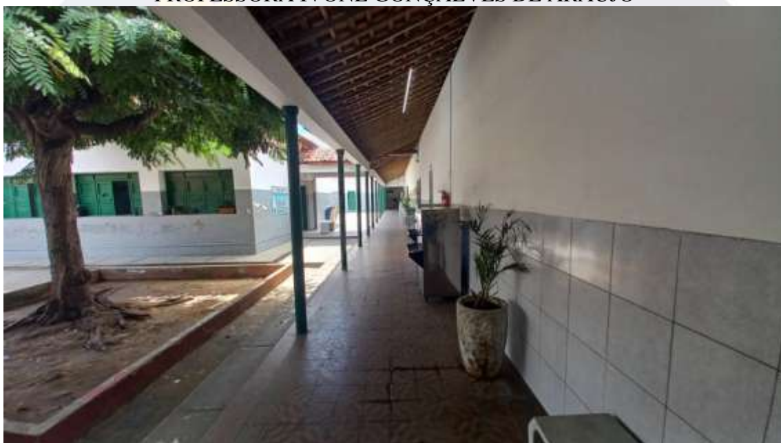
Figura 83. CONSTRUÇÃO DE SALAS DE AULAS NA ESCOLA MUNICIPAL PROFESSORA IVONE GONÇALVES DE ARAÚJO
