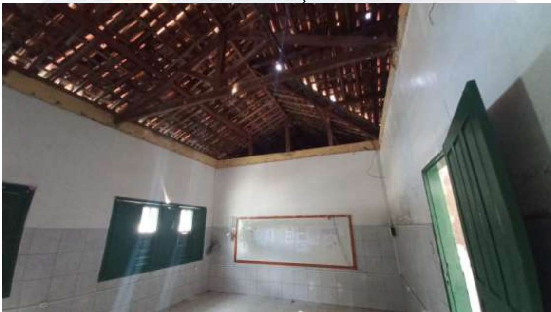
Figura 55. CONSTRUÇÃO DE SALAS DE AULAS NA ESCOLA MUNICIPAL PROFESSORA IVONE GONÇALVES DE ARAÚJO
