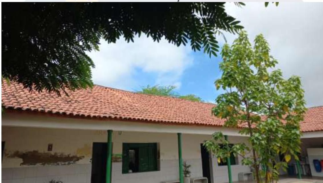
Figura 27. CONSTRUÇÃO DE SALAS DE AULAS NA ESCOLA MUNICIPAL PROFESSORA IVONE GONÇALVES DE ARAÚJO
