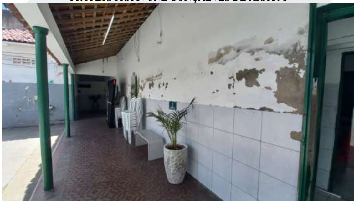
Figura 41. CONSTRUÇÃO DE SALAS DE AULAS NA ESCOLA MUNICIPAL PROFESSORA IVONE GONÇALVES DE ARAÚJO
