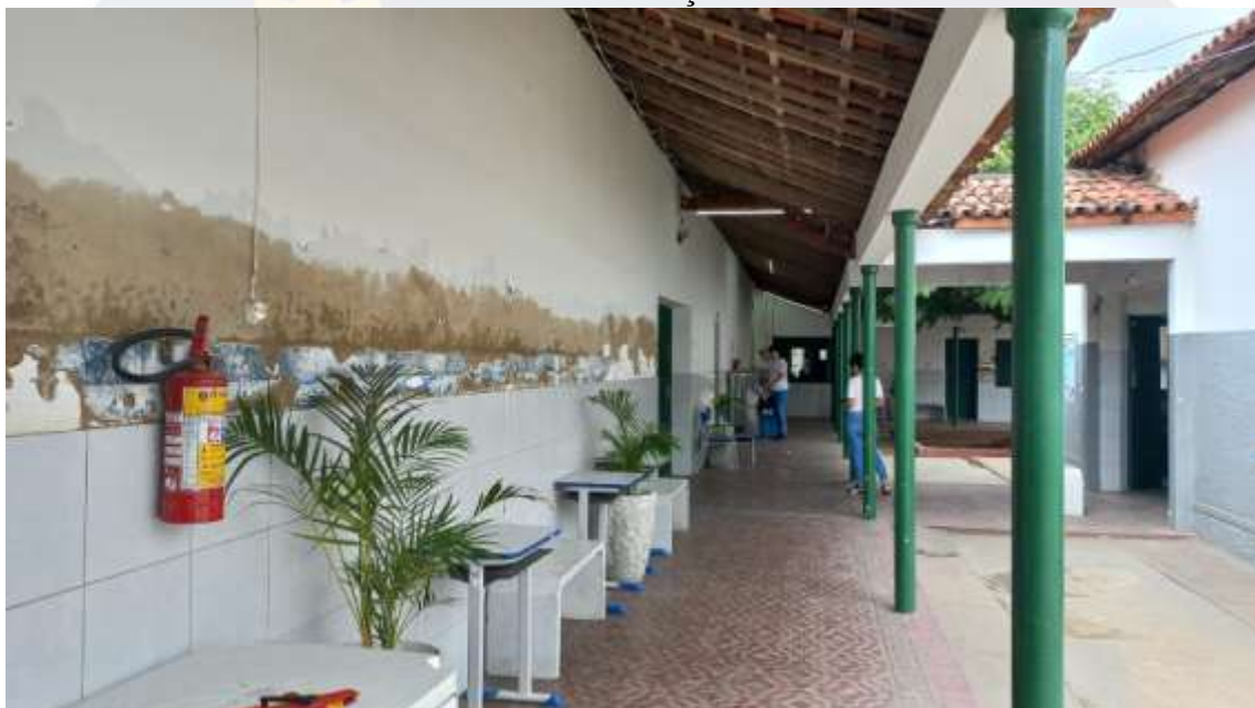
Figura 25. CONSTRUÇÃO DE SALAS DE AULAS NA ESCOLA MUNICIPAL PROFESSORA IVONE GONÇALVES DE ARAÚJO
