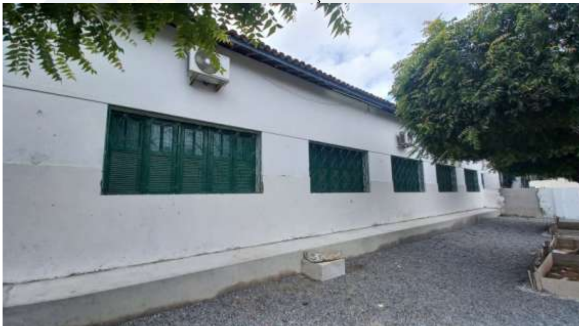
Figura 13. CONSTRUÇÃO DE SALAS DE AULAS NA ESCOLA MUNICIPAL PROFESSORA IVONE GONÇALVES DE ARAÚJO
