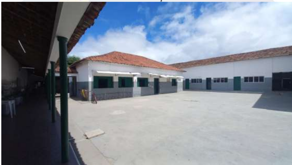
Figura 57. CONSTRUÇÃO DE SALAS DE AULAS NA ESCOLA MUNICIPAL PROFESSORA IVONE GONÇALVES DE ARAÚJO
