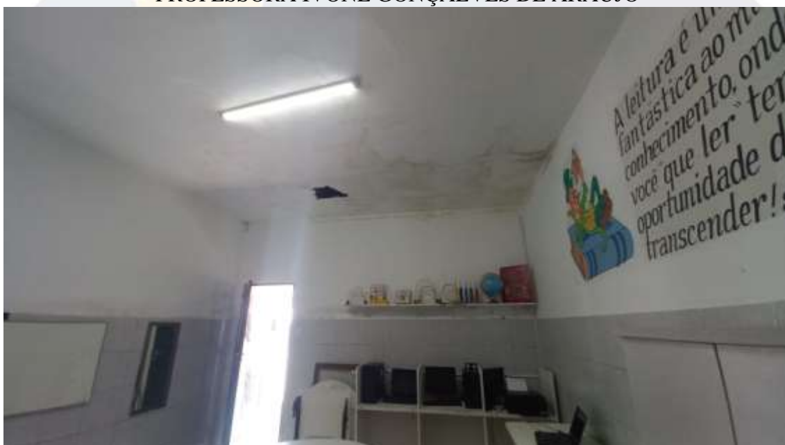
Figura 49. CONSTRUÇÃO DE SALAS DE AULAS NA ESCOLA MUNICIPAL PROFESSORA IVONE GONÇALVES DE ARAÚJO
