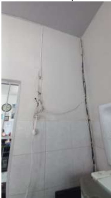
Figura 32. CONSTRUÇÃO DE SALAS DE AULAS NA ESCOLA MUNICIPAL PROFESSORA IVONE GONÇALVES DE ARAÚJO
