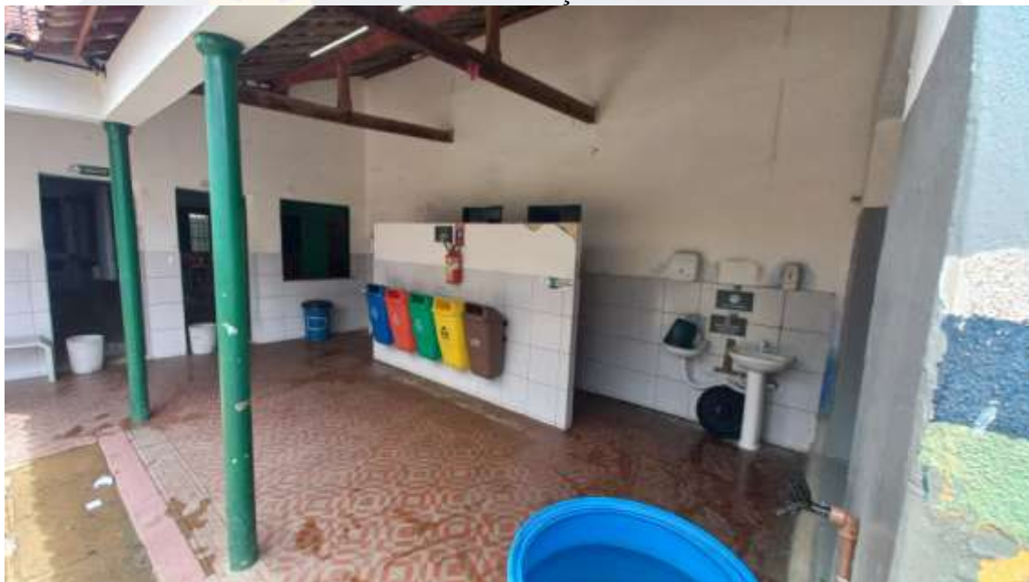
Figura 75. CONSTRUÇÃO DE SALAS DE AULAS NA ESCOLA MUNICIPAL PROFESSORA IVONE GONÇALVES DE ARAÚJO
