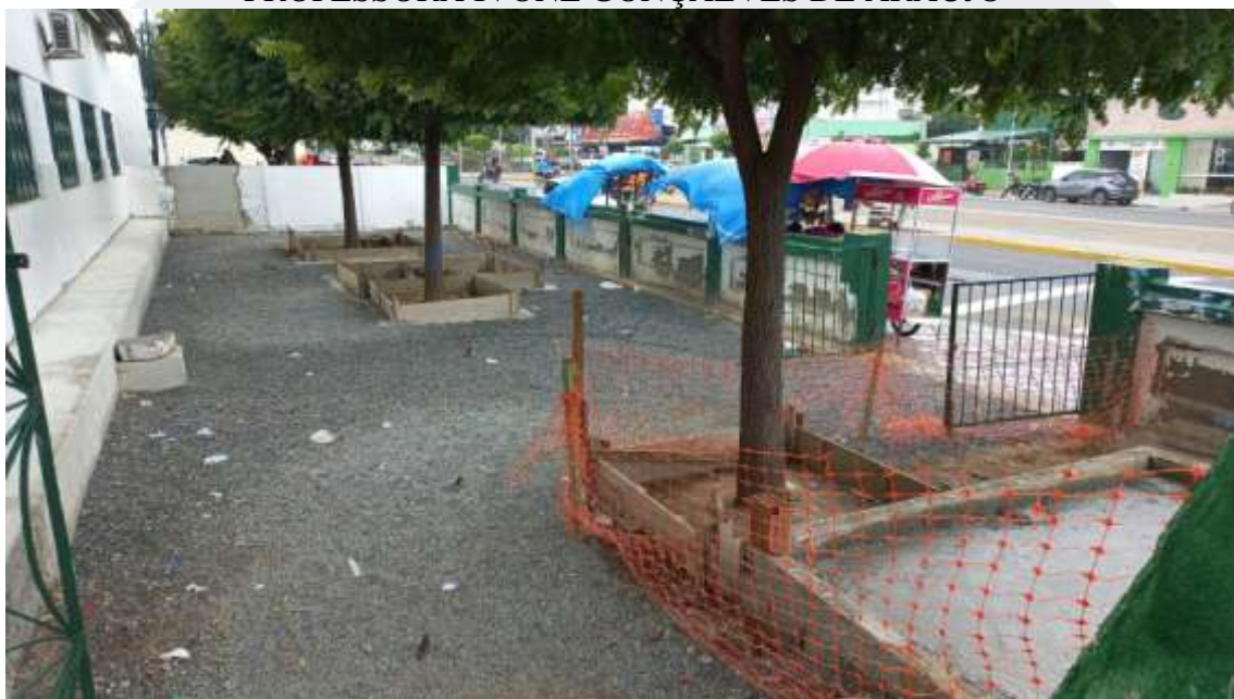
Figura 85. CONSTRUÇÃO DE SALAS DE AULAS NA ESCOLA MUNICIPAL PROFESSORA IVONE GONÇALVES DE ARAÚJO
