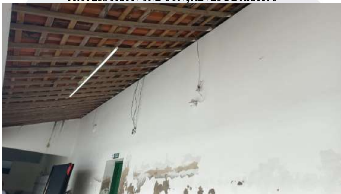
Figura 21. CONSTRUÇÃO DE SALAS DE AULAS NA ESCOLA MUNICIPAL PROFESSORA IVONE GONÇALVES DE ARAÚJO
