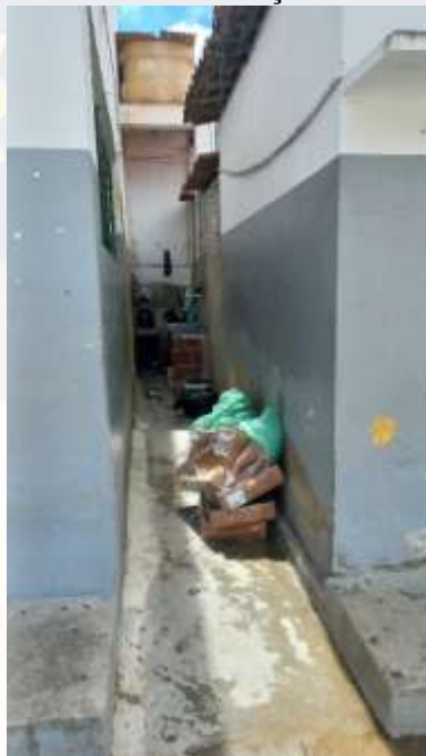
Figura 69. CONSTRUÇÃO DE SALAS DE AULAS NA ESCOLA MUNICIPAL PROFESSORA IVONE GONÇALVES DE ARAÚJO
