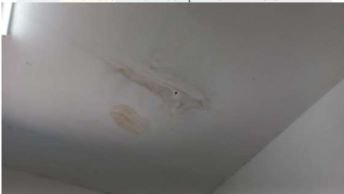
Figura 37. CONSTRUÇÃO DE SALAS DE AULAS NA ESCOLA MUNICIPAL PROFESSORA IVONE GONÇALVES DE ARAÚJO
