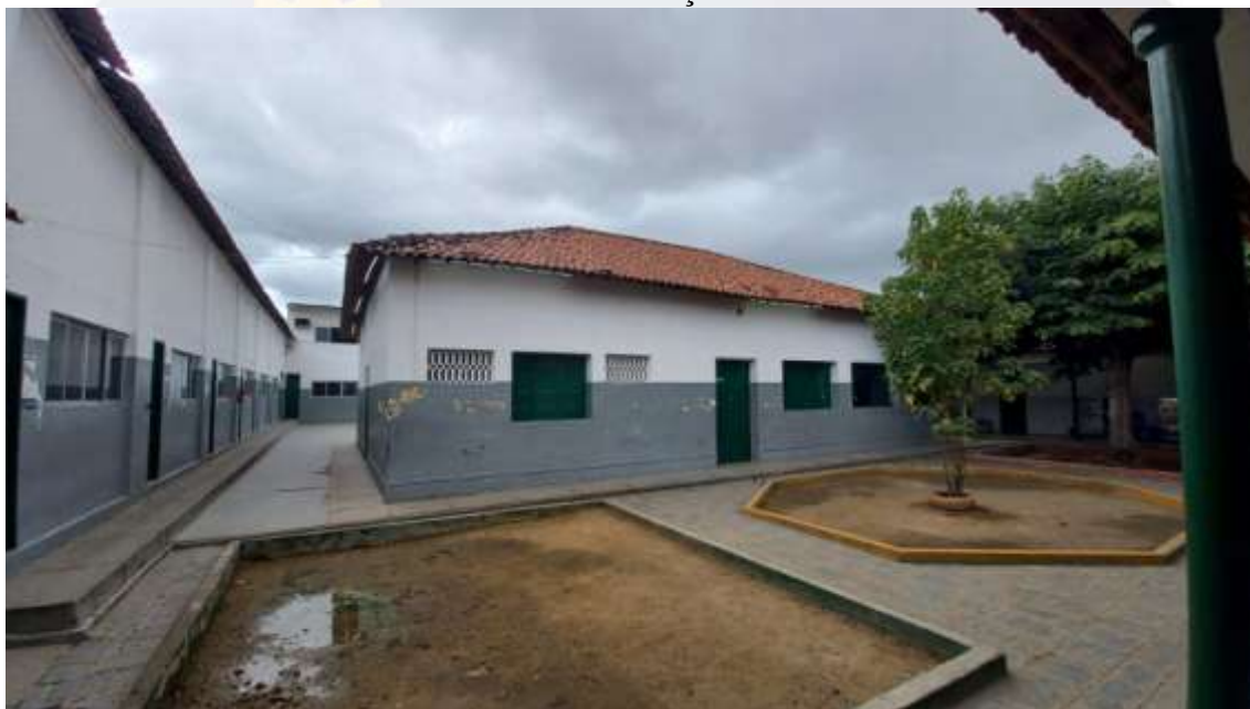
Figura 19. CONSTRUÇÃO DE SALAS DE AULAS NA ESCOLA MUNICIPAL PROFESSORA IVONE GONÇALVES DE ARAÚJO
