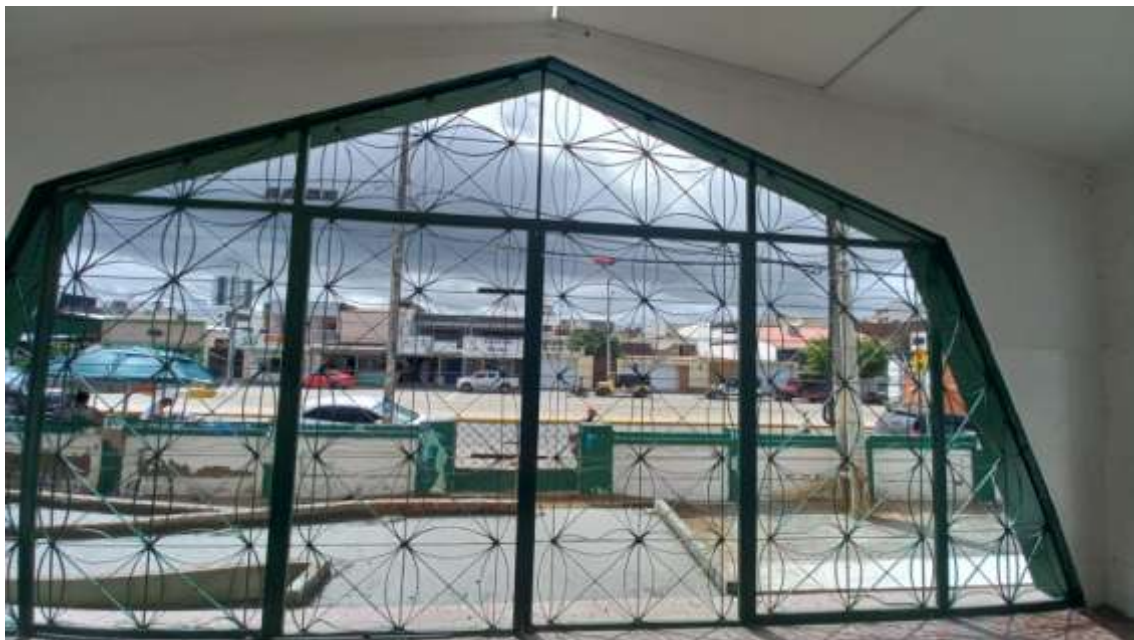
Figura 4. CONSTRUÇÃO DE SALAS DE AULAS NA ESCOLA MUNICIPAL PROFESSORA IVONE GONÇALVES DE ARAÚJO
