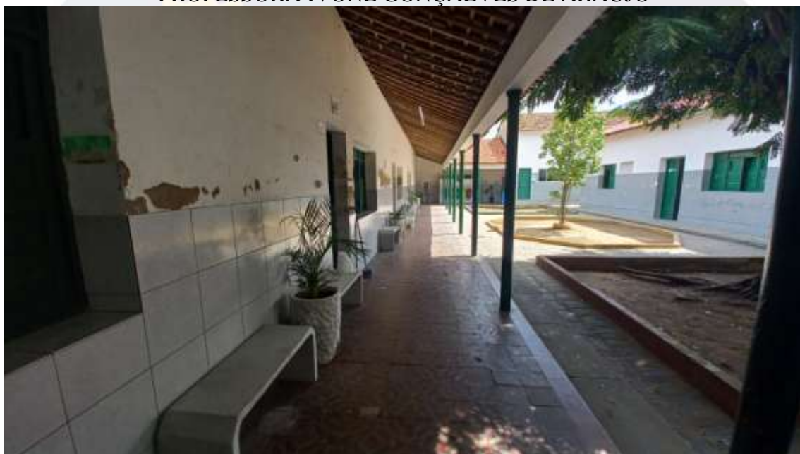
Figura 79. CONSTRUÇÃO DE SALAS DE AULAS NA ESCOLA MUNICIPAL PROFESSORA IVONE GONÇALVES DE ARAÚJO
