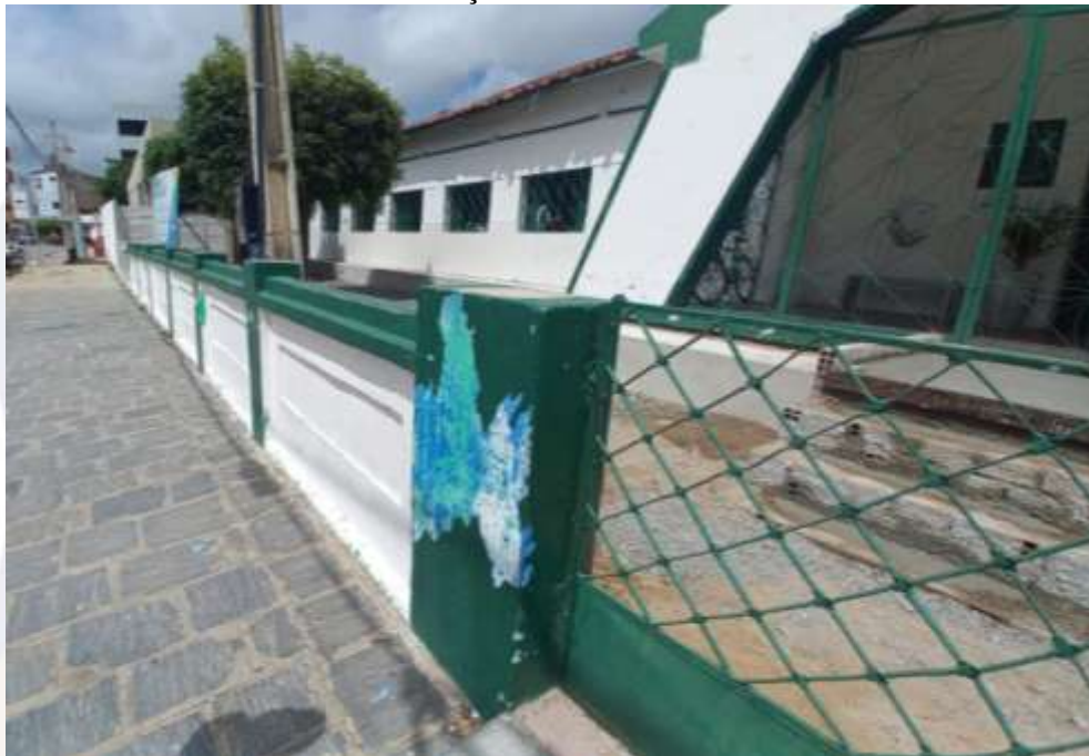
Figura 1. CONSTRUÇÃO DE SALAS DE AULAS NA ESCOLA MUNICIPAL PROFESSORA IVONE GONÇALVES DE ARAÚJO
