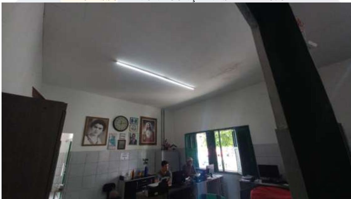
Figura 35. CONSTRUÇÃO DE SALAS DE AULAS NA ESCOLA MUNICIPAL PROFESSORA IVONE GONÇALVES DE ARAÚJO
