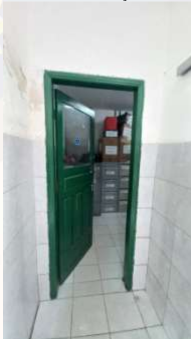
Figura 45. CONSTRUÇÃO DE SALAS DE AULAS NA ESCOLA MUNICIPAL PROFESSORA IVONE GONÇALVES DE ARAÚJO
