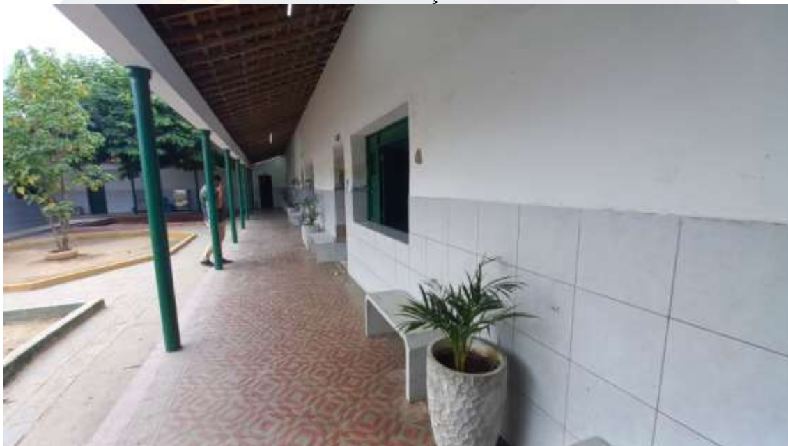
Figura 17. CONSTRUÇÃO DE SALAS DE AULAS NA ESCOLA MUNICIPAL PROFESSORA IVONE GONÇALVES DE ARAÚJO
