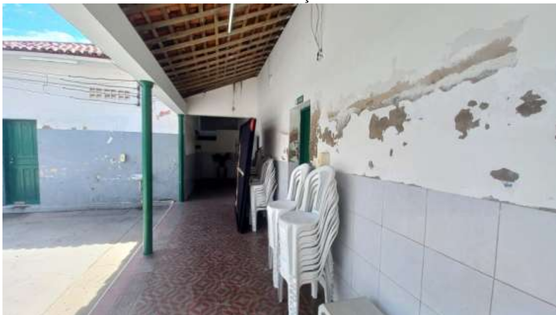
Figura 48. CONSTRUÇÃO DE SALAS DE AULAS NA ESCOLA MUNICIPAL PROFESSORA IVONE GONÇALVES DE ARAÚJO
