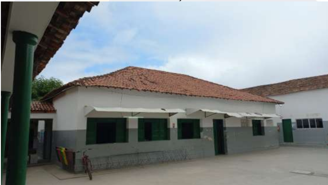
Figura 29. CONSTRUÇÃO DE SALAS DE AULAS NA ESCOLA MUNICIPAL PROFESSORA IVONE GONÇALVES DE ARAÚJO
