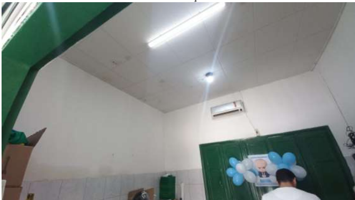
Figura 36. CONSTRUÇÃO DE SALAS DE AULAS NA ESCOLA MUNICIPAL PROFESSORA IVONE GONÇALVES DE ARAÚJO
