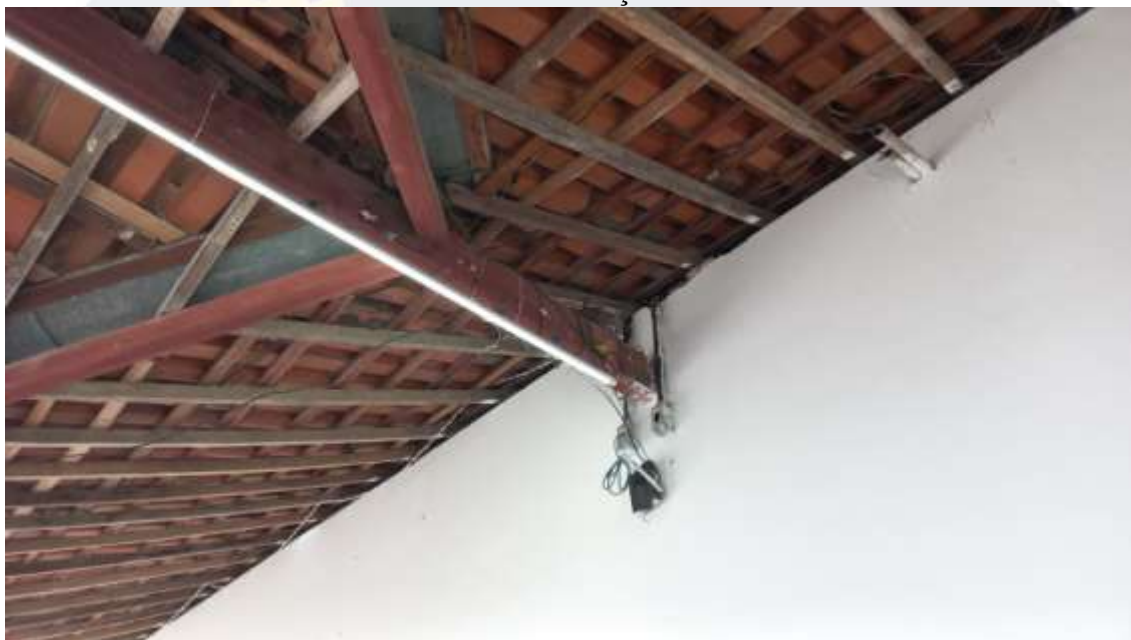
Figura 23. CONSTRUÇÃO DE SALAS DE AULAS NA ESCOLA MUNICIPAL PROFESSORA IVONE GONÇALVES DE ARAÚJO
