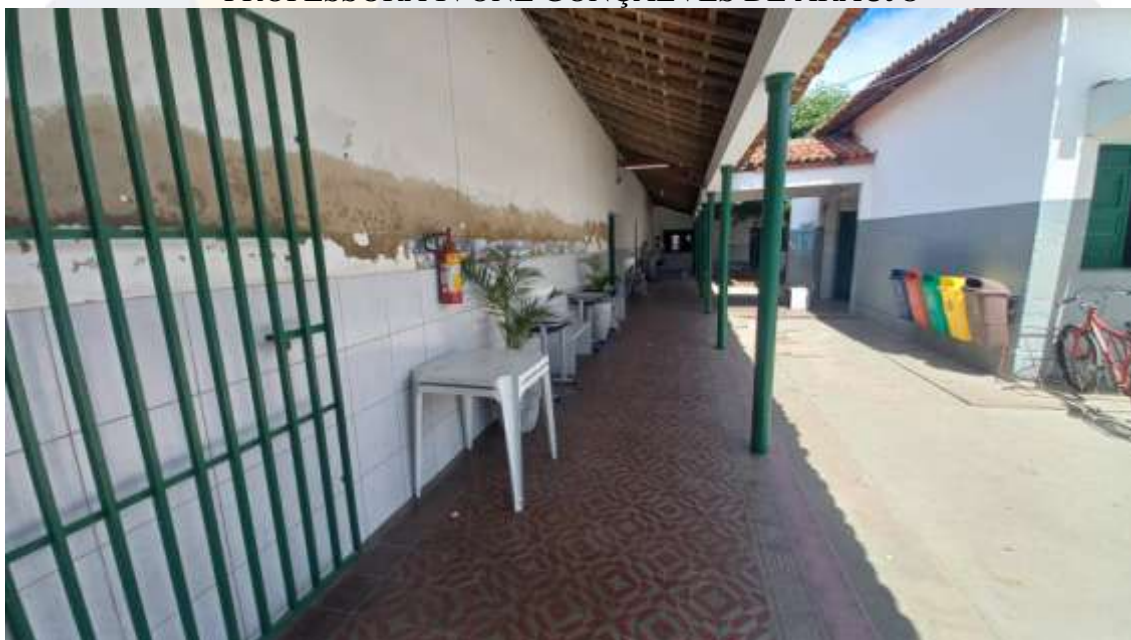
Figura 43. CONSTRUÇÃO DE SALAS DE AULAS NA ESCOLA MUNICIPAL PROFESSORA IVONE GONÇALVES DE ARAÚJO
