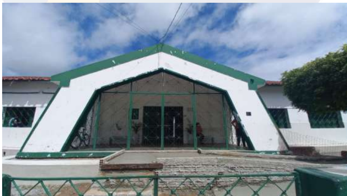
Figura 5. CONSTRUÇÃO DE SALAS DE AULAS NA ESCOLA MUNICIPAL PROFESSORA IVONE GONÇALVES DE ARAÚJO
