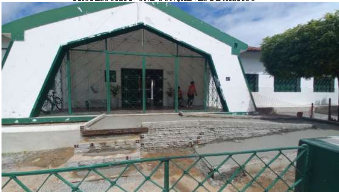
Figura 2. CONSTRUÇÃO DE SALAS DE AULAS NA ESCOLA MUNICIPAL PROFESSORA IVONE GONÇALVES DE ARAÚJO
