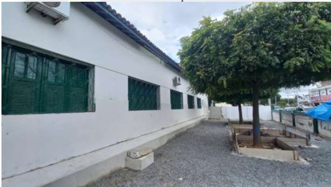
Figura 11. CONSTRUÇÃO DE SALAS DE AULAS NA ESCOLA MUNICIPAL PROFESSORA IVONE GONÇALVES DE ARAÚJO
