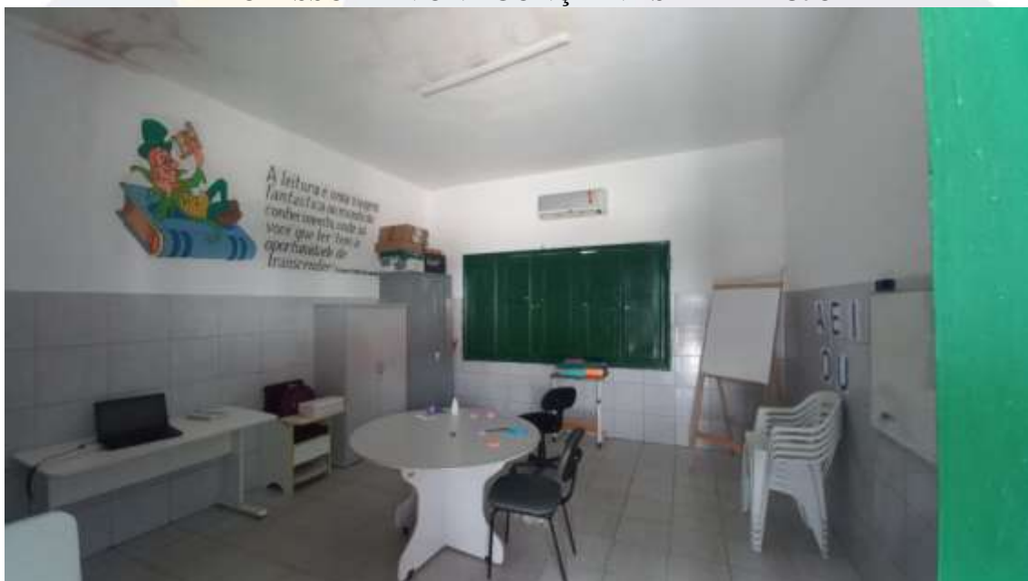
Figura 47. CONSTRUÇÃO DE SALAS DE AULAS NA ESCOLA MUNICIPAL PROFESSORA IVONE GONÇALVES DE ARAÚJO
