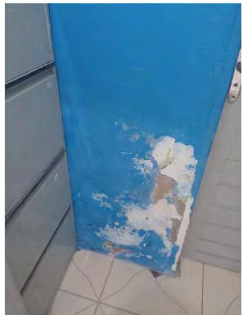
SALA DE VACINA COM INFILTRAÇÕES E MOFO NAS PAREDES, GOTEIRA NO GESSO, PORTA QUE NÃO FECHA DIFICULTANDO A CLIMATIZAÇÃO DO AMBIENTE, FALTA DE ISOPOR PEQUENO PARA ATENDIMENTO A DOMICÍLIO.
