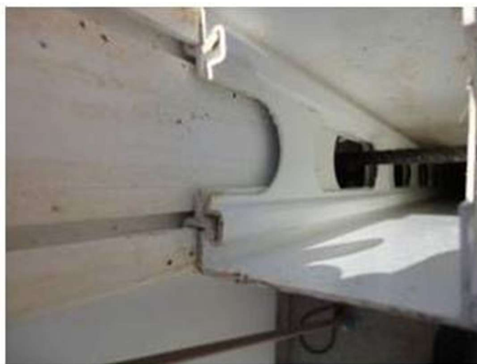
FIGURA 20 – Ferragem posicionada na região da contra-verga
