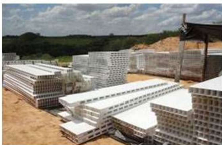
FIGURA 18 – Painéis de PVC pré-moldados na fábrica
