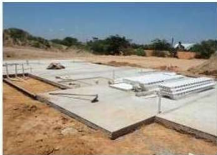
FIGURA 16 – Elemento de fundação com planicidade adequada
