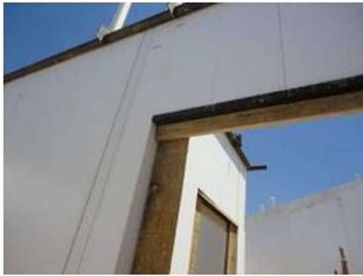
FIGURA 21 – Escoramento de aberturas de portas para concretagem
