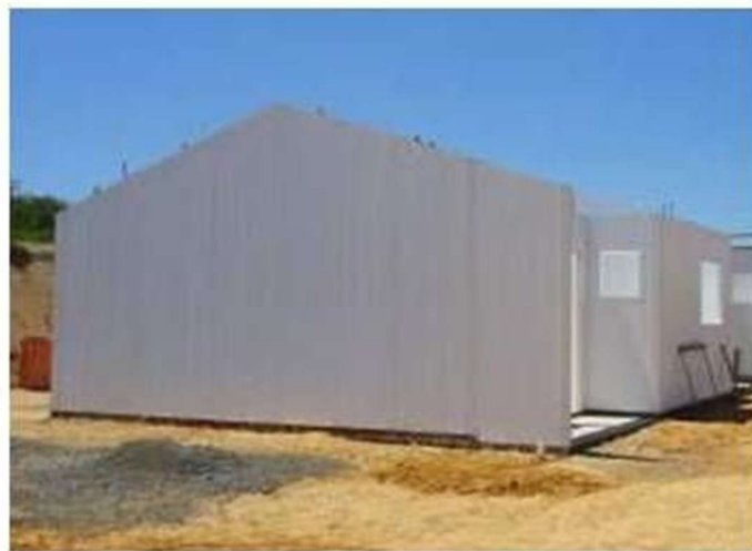
FIGURA 22 – Painéis de PVC concretados
