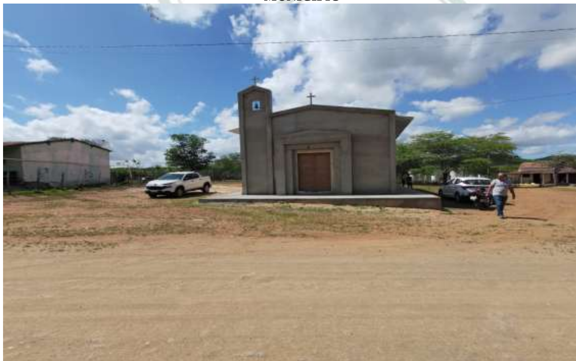
Figura 4. PAVIMENTAÇÃO DE VIAS EM PARALELEPÍPEDO NA ZONA RURAL DO MUNICÍPIO
