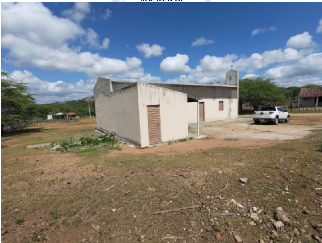
Figura 1. PAVIMENTAÇÃO DE VIAS EM PARALELEPÍPEDO NA ZONA RURAL DO MUNICÍPIO
