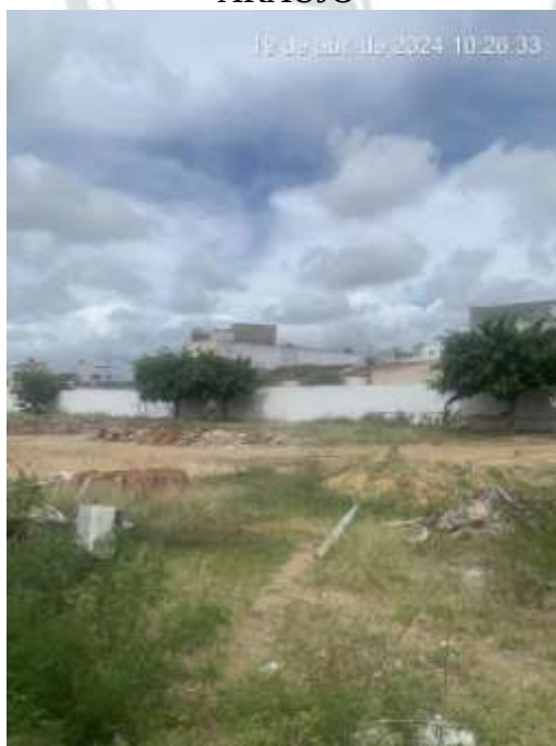
Figura 7. CONSTRUÇÃO DE QUADRA COBERTA ABERTA 35M/S, PADRÃO FNDE, NA ESCOLA MUNICIPAL PROFESSORA IVONE GONCALVES DE ARAUJO
