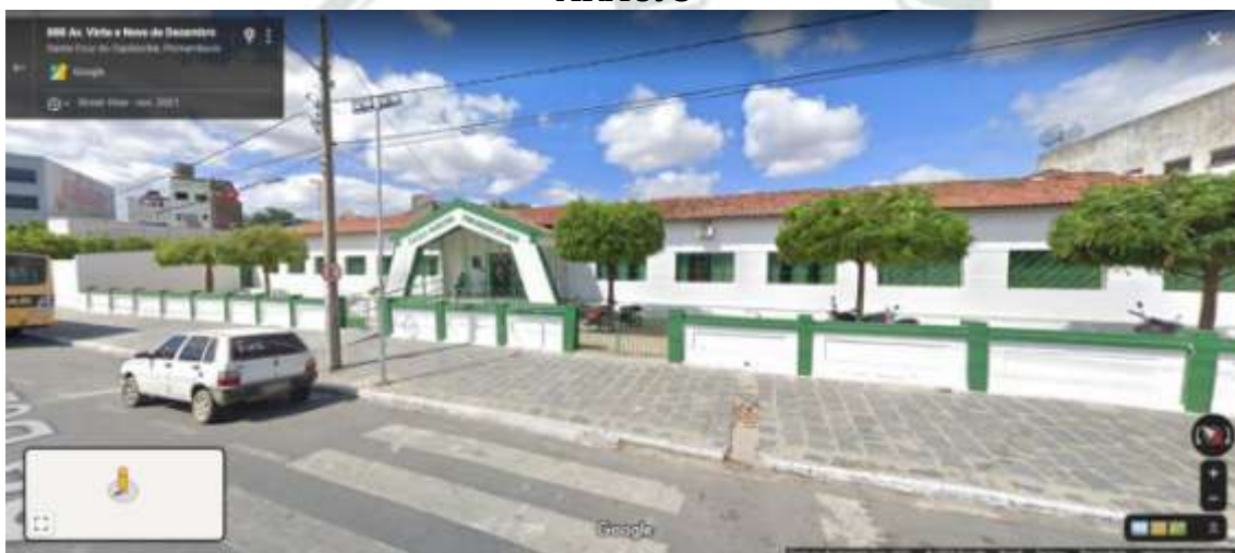
Figura 17. CONSTRUÇÃO DE QUADRA COBERTA ABERTA 35M/S, PADRÃO FNDE, NA ESCOLA MUNICIPAL PROFESSORA IVONE GONCALVES DE ARAUJO
