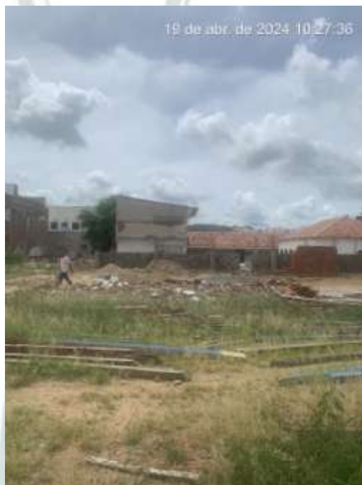
Figura 5. CONSTRUÇÃO DE QUADRA COBERTA ABERTA 35M/S, PADRÃO FNDE, NA ESCOLA MUNICIPAL PROFESSORA IVONE GONCALVES DE ARAUJO
