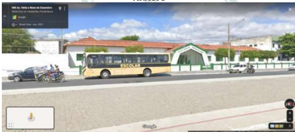
Figura 11. CONSTRUÇÃO DE QUADRA COBERTA ABERTA 35M/S, PADRÃO FNDE, NA ESCOLA MUNICIPAL PROFESSORA IVONE GONCALVES DE ARAUJO
