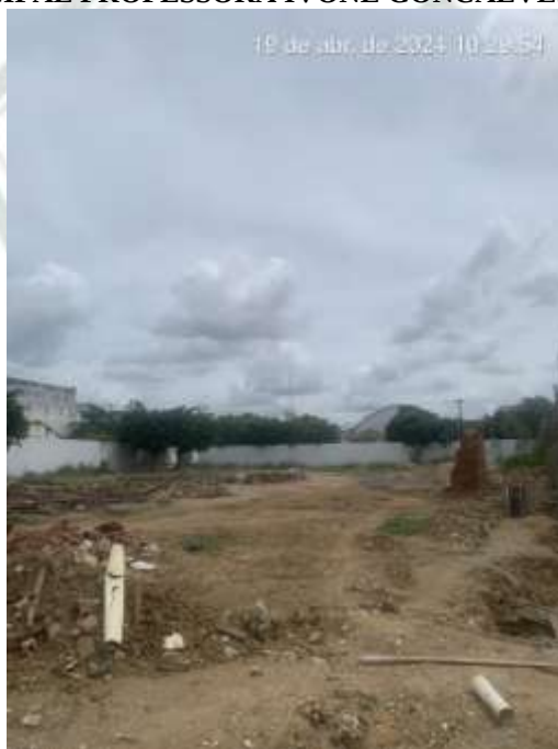
Figura 1. CONSTRUÇÃO DE QUADRA COBERTA ABERTA 35M/S, PADRÃO FNDE, NA ESCOLA MUNICIPAL PROFESSORA IVONE GONCALVES DE ARAUJO
