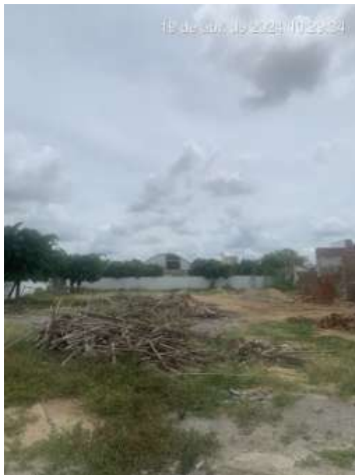
Figura 4. CONSTRUÇÃO DE QUADRA COBERTA ABERTA 35M/S, PADRÃO FNDE, NA ESCOLA MUNICIPAL PROFESSORA IVONE GONCALVES DE ARAUJO
