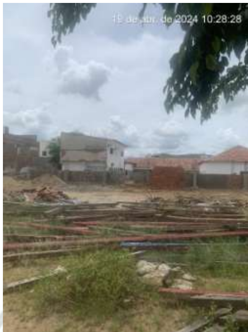
Figura 6. CONSTRUÇÃO DE QUADRA COBERTA ABERTA 35M/S, PADRÃO FNDE, NA ESCOLA MUNICIPAL PROFESSORA IVONE GONCALVES DE ARAUJO
