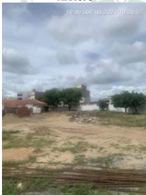
Figura 9. CONSTRUÇÃO DE QUADRA COBERTA ABERTA 35M/S, PADRÃO FNDE, NA ESCOLA MUNICIPAL PROFESSORA IVONE GONCALVES DE ARAUJO
