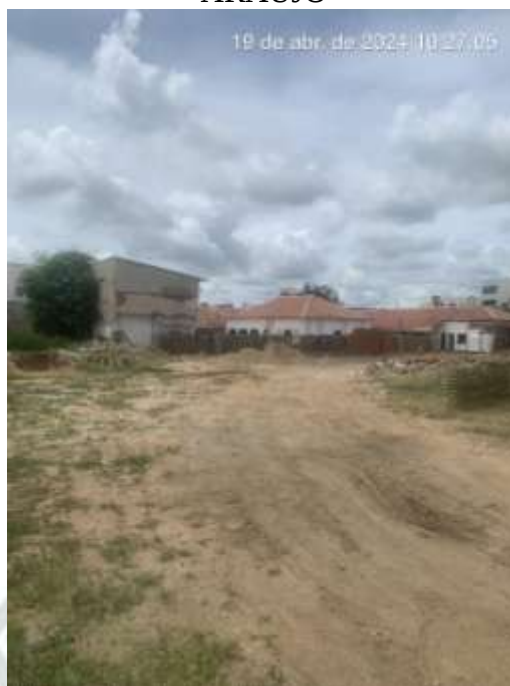
Figura 8. CONSTRUÇÃO DE QUADRA COBERTA ABERTA 35M/S, PADRÃO FNDE, NA ESCOLA MUNICIPAL PROFESSORA IVONE GONCALVES DE ARAUJO
