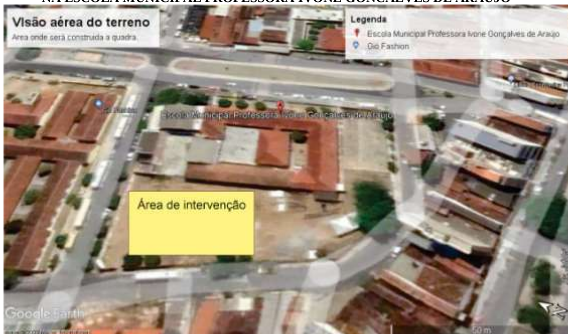
Figura 2. CONSTRUÇÃO DE QUADRA COBERTA ABERTA 35M/S, PADRÃO FNDE, NA ESCOLA MUNICIPAL PROFESSORA IVONE GONCALVES DE ARAUJO
