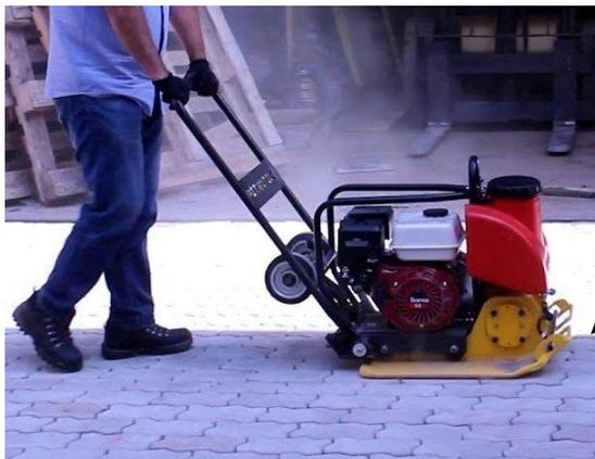
Placa vibratória que tem a função de compactar todos os blocos de intertravados para um melhor assentamento dos mesmos.
