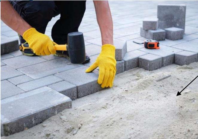
Execução de Pavimento com intertravado sobre colchão de areia/pó de pedra.
