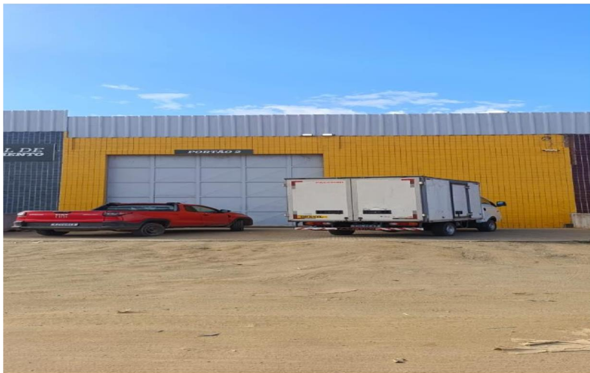
Vista do Imóvel Avaliando
