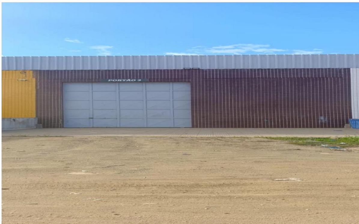
Vista do Imóvel Avaliando
