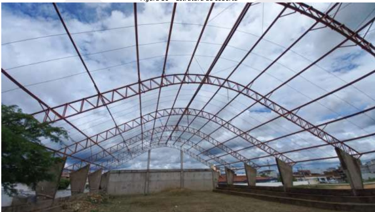
Figura 36 – Estrutura de cobertura
