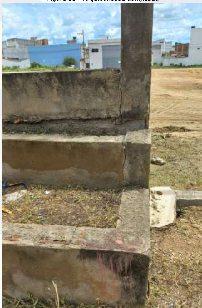
Figura 58 – Arquibancada danificada
