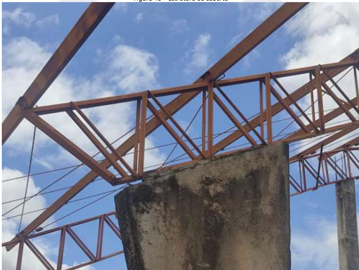
Figura 40 – Estrutura de cobertura
