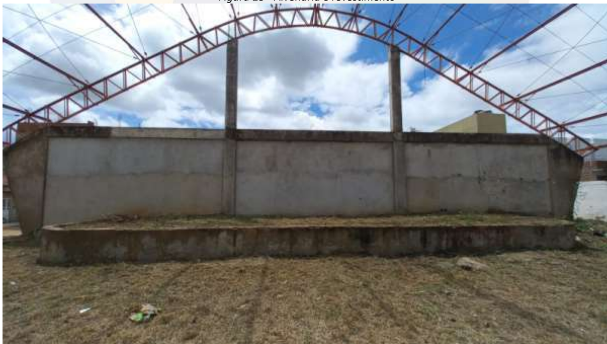
Figura 25 - Alvenaria e revestimento
