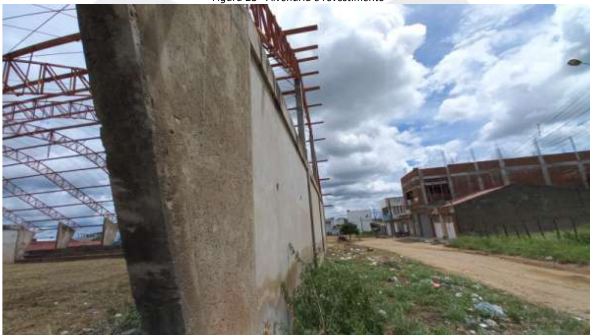
Figura 23 - Alvenaria e revestimento
