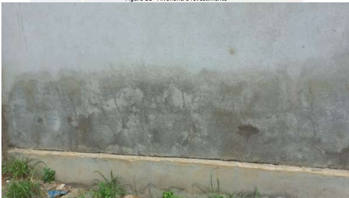
Figura 21 - Alvenaria e revestimento
