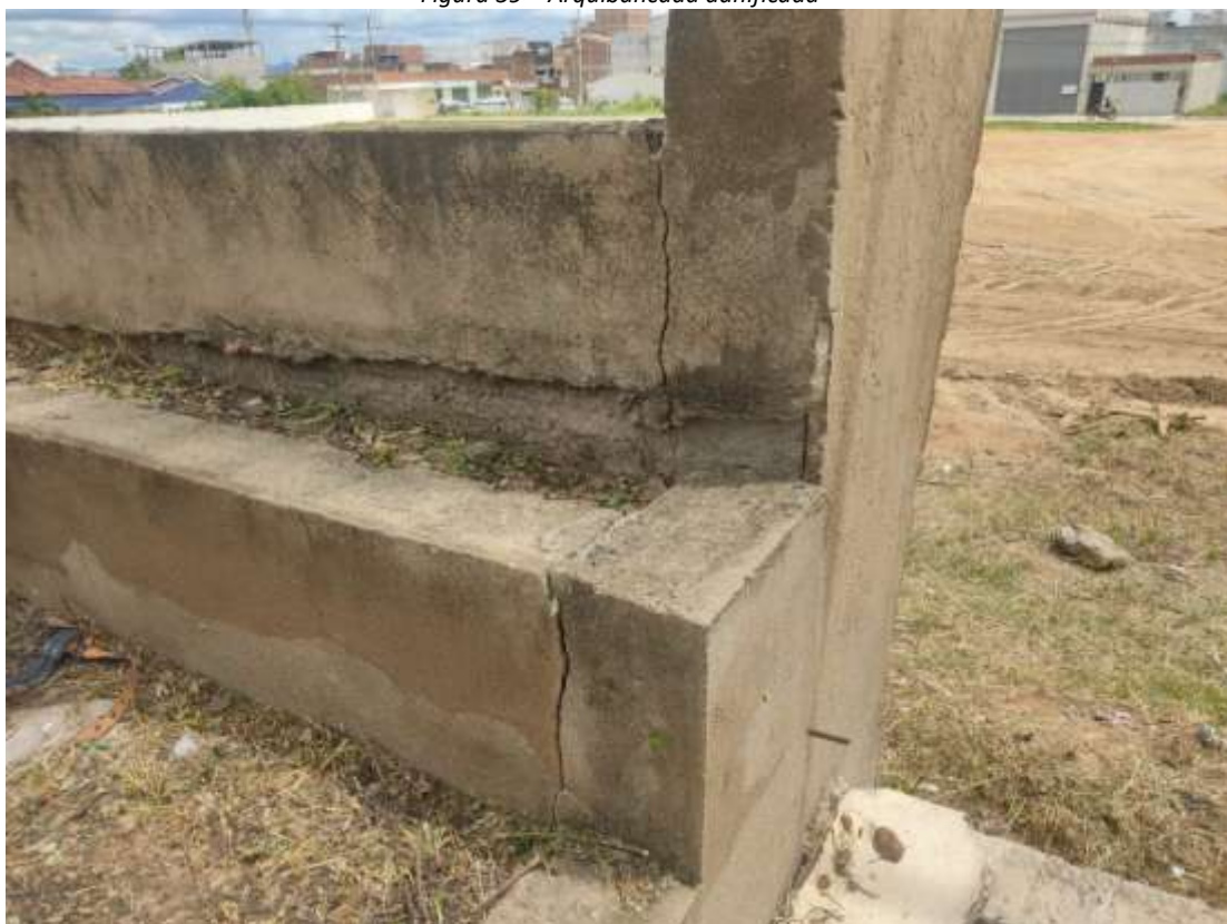
Figura 59 – Arquibancada danificada
