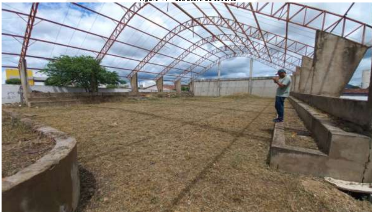
Figura 44 – Estrutura de cobertura
