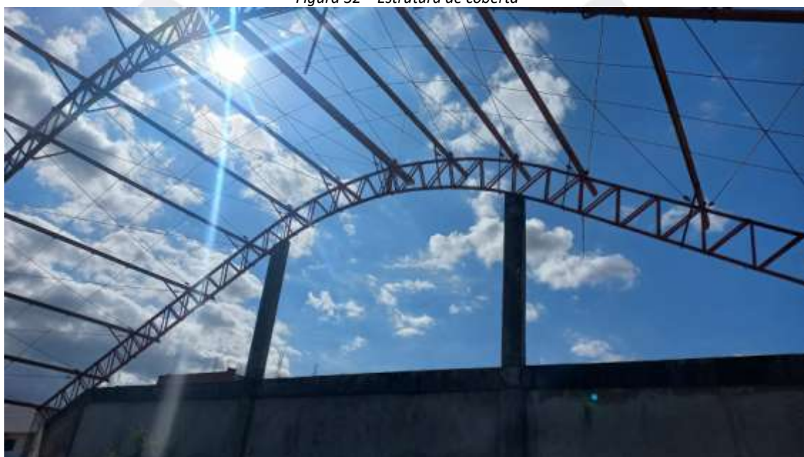
Figura 32 – Estrutura de cobertura
