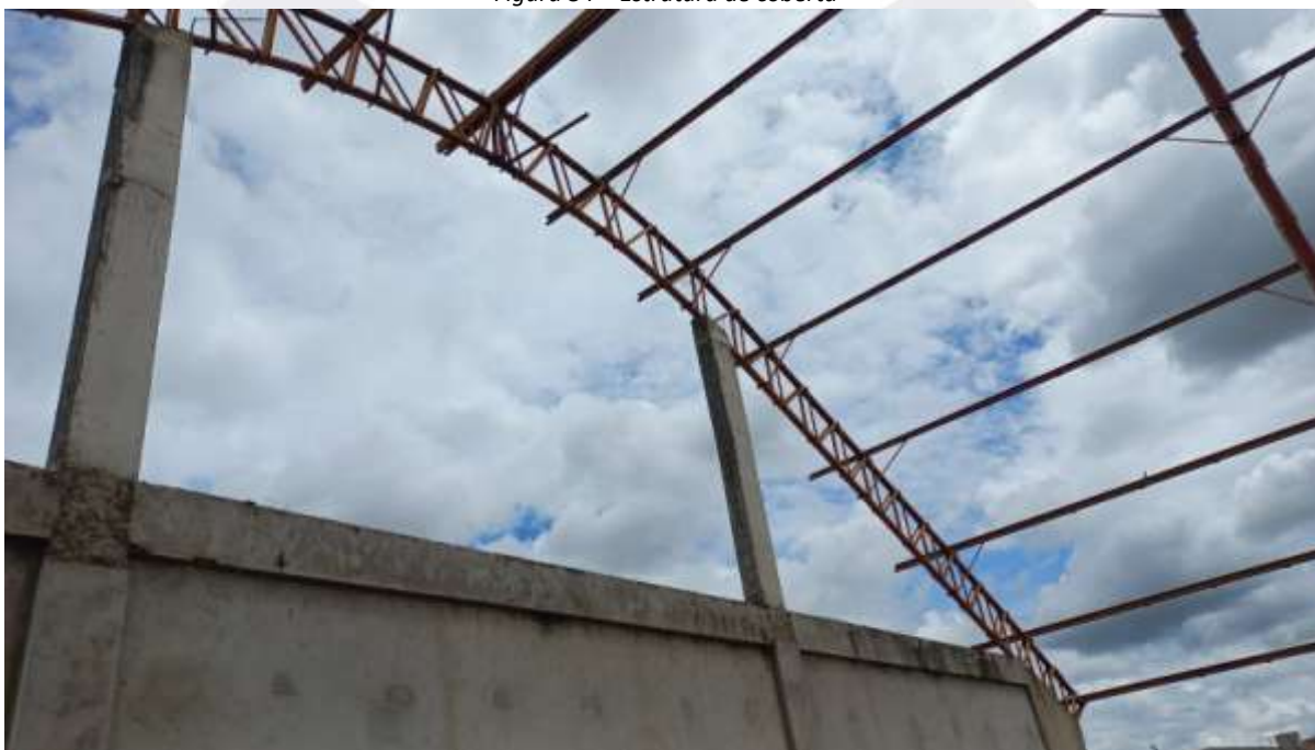
Figura 34 – Estrutura de cobertura
