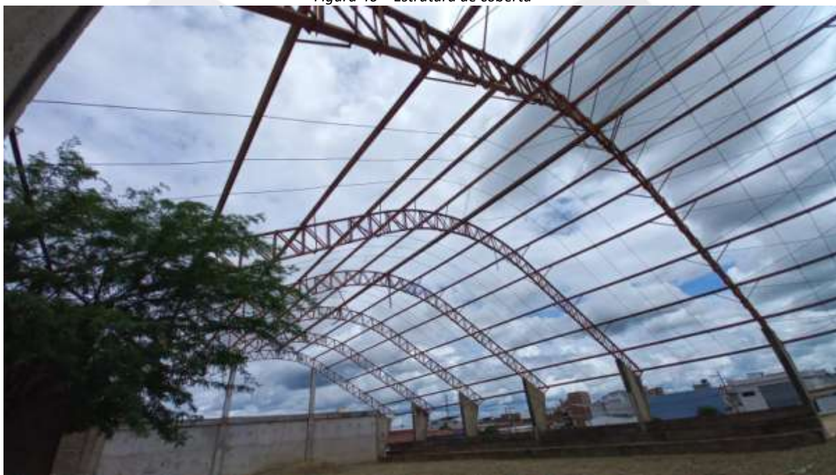
Figura 46 – Estrutura de cobertura
