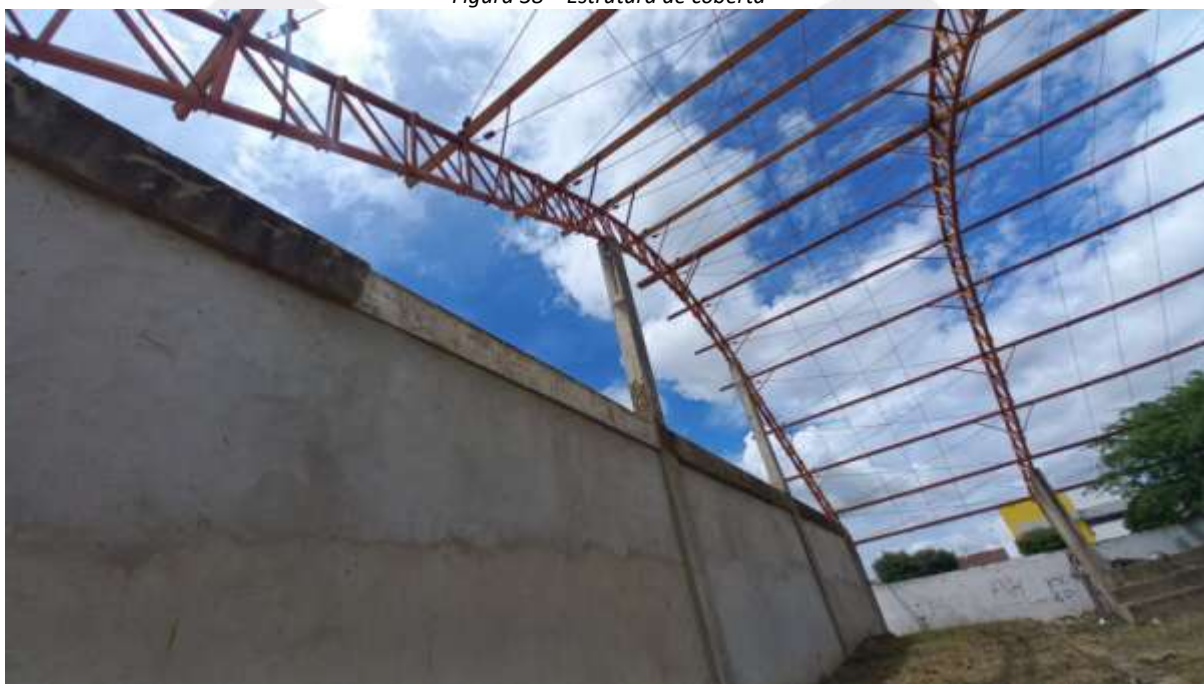
Figura 38 – Estrutura de cobertura
