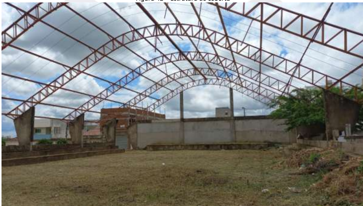
Figura 42 – Estrutura de cobertura
