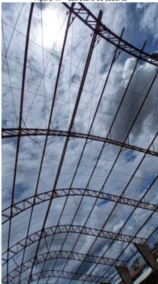
Figura 47 – Estrutura de cobertura
