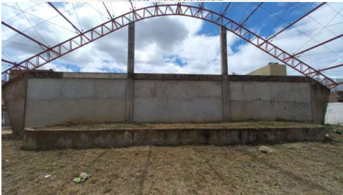
Figura 25 - Alvenaria e revestimento
