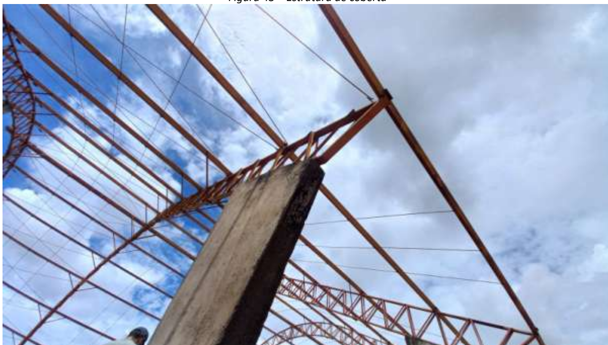
Figura 43 – Estrutura de cobertura
