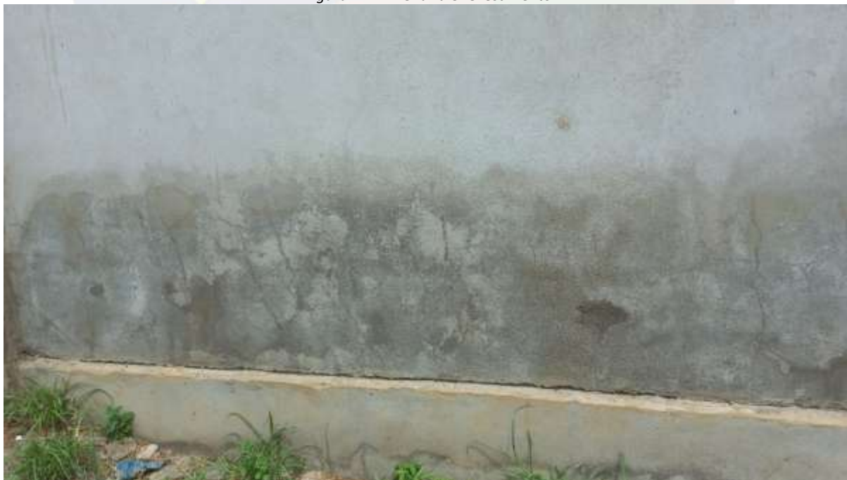
Figura 21 - Alvenaria e revestimento
