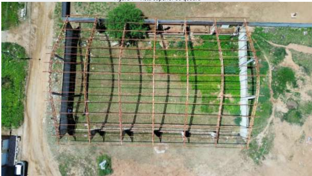
Figura 7 - Vista superior da quadra
