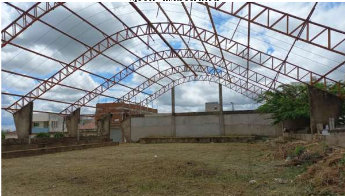
Figura 35 – Estrutura de cobertura
