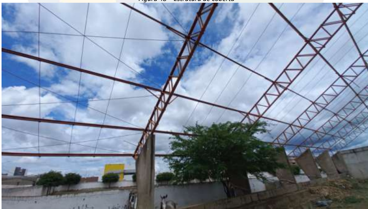
Figura 48 – Estrutura de cobertura
