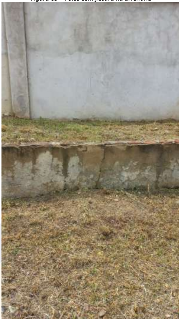
Figura 69 – Palco com fissura na alvenaria
