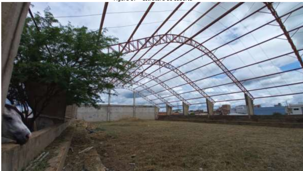
Figura 37 – Estrutura de cobertura
