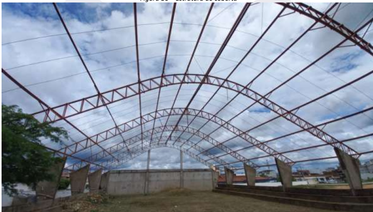
Figura 36 – Estrutura de cobertura
