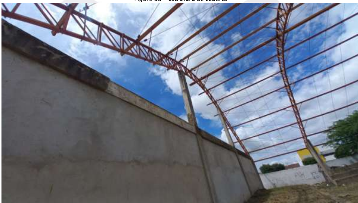
Figura 38 – Estrutura de cobertura
