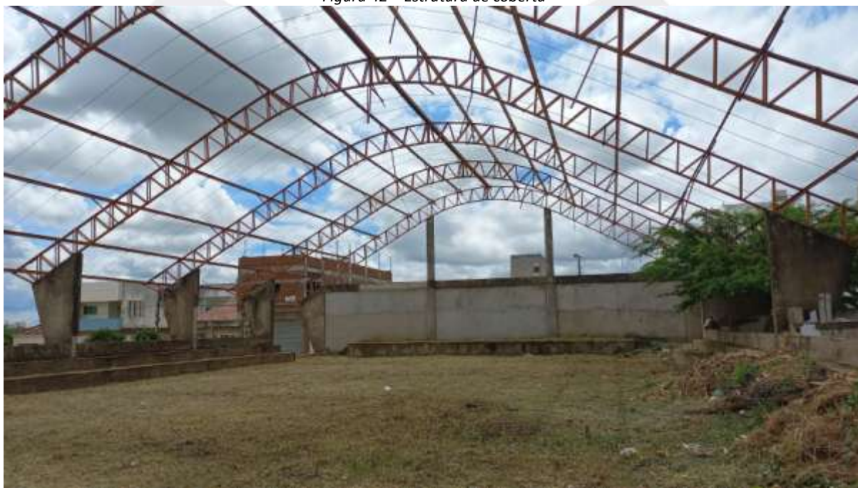
Figura 42 – Estrutura de cobertura
