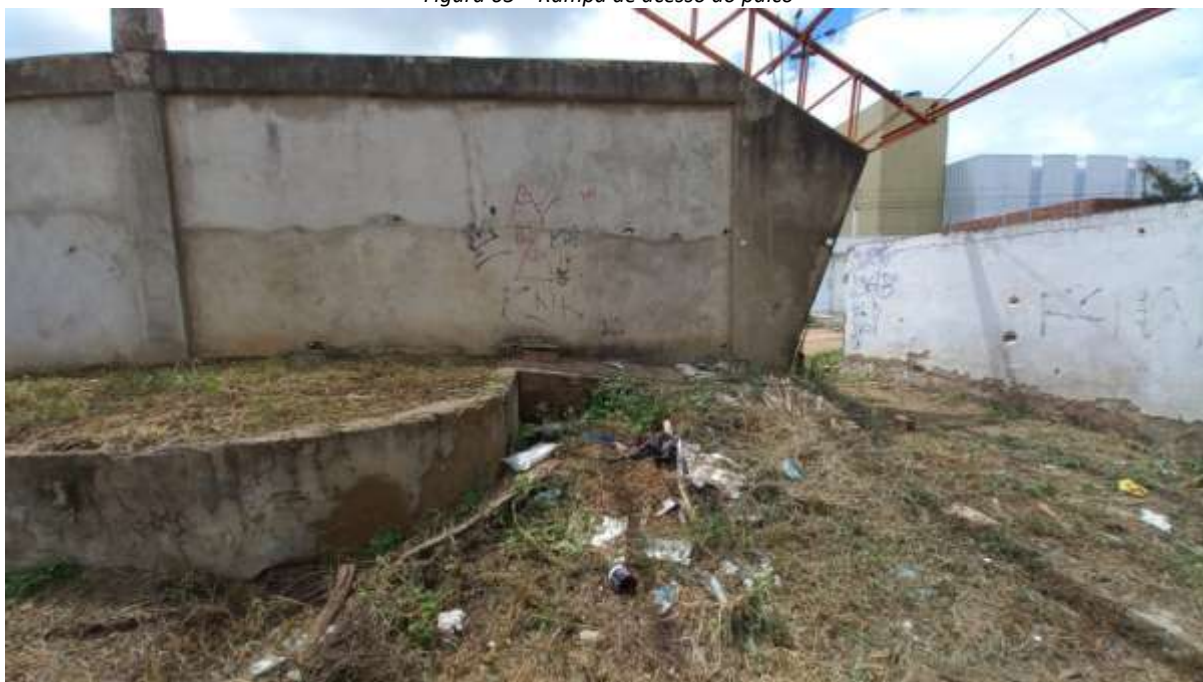
Figura 65 – Rampa de acesso ao palco
