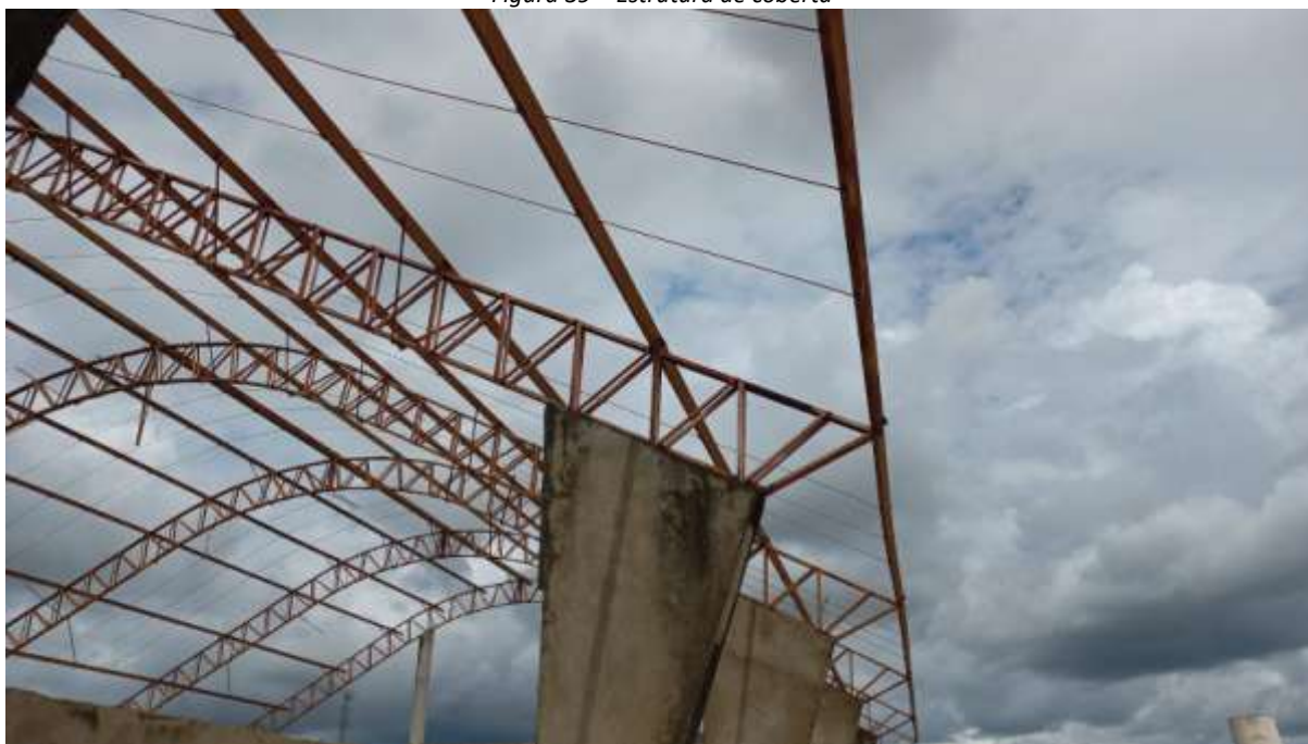
Figura 39 – Estrutura de cobertura
