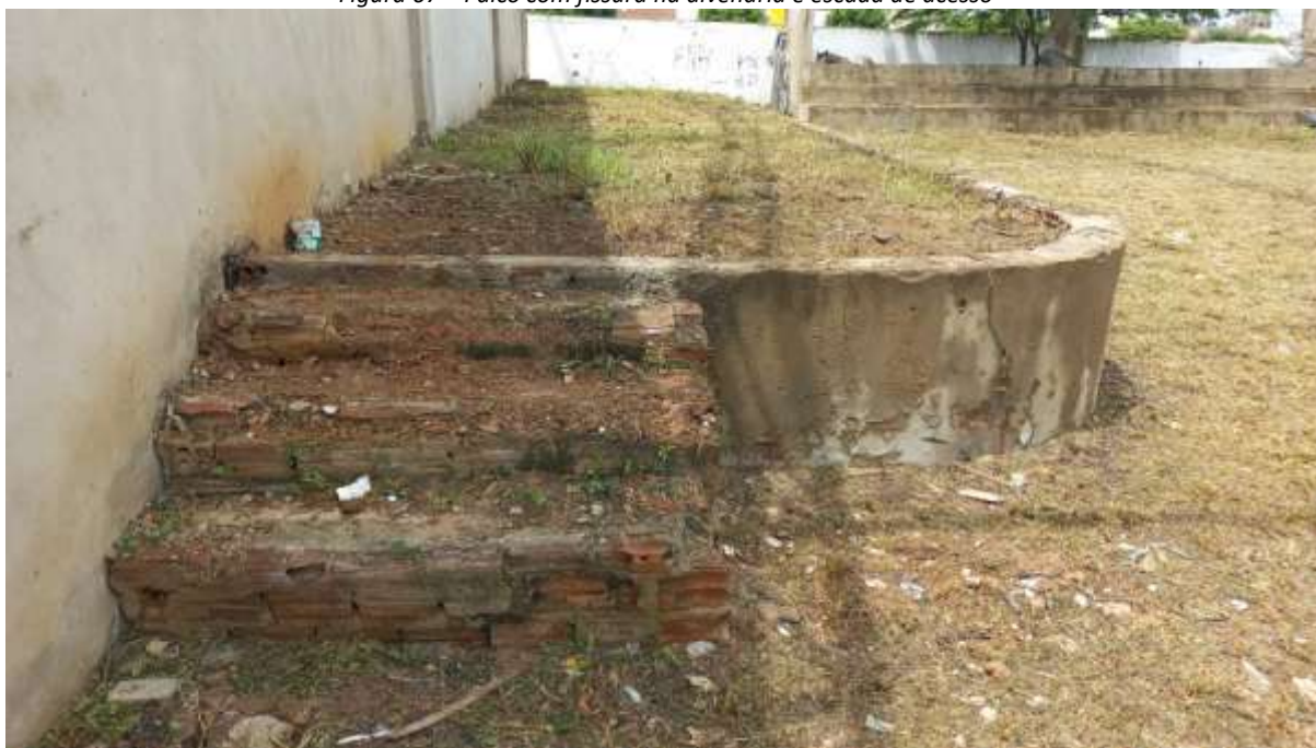
Figura 67 – Palco com fissura na alvenaria e escada de acesso
