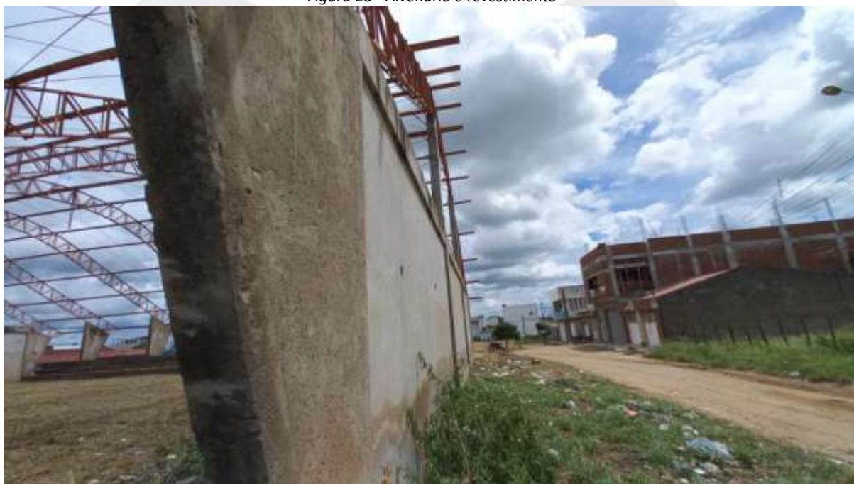
Figura 23 - Alvenaria e revestimento
