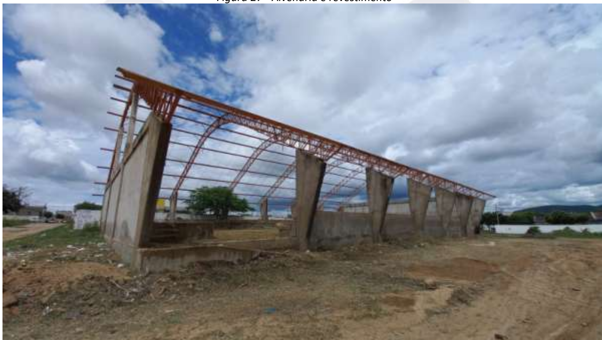
Figura 27 - Alvenaria e revestimento
