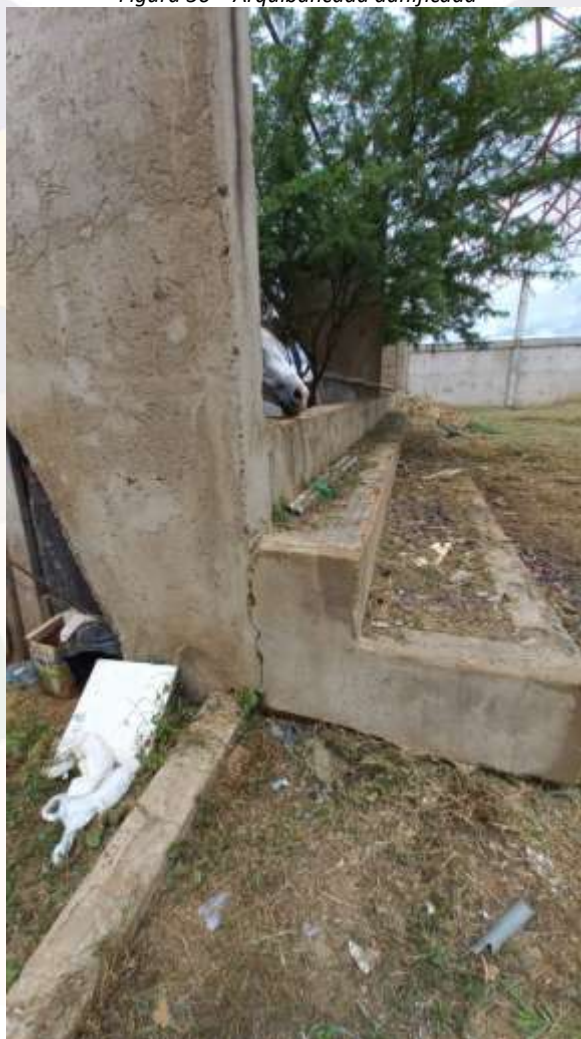
Figura 56 – Arquibancada danificada
