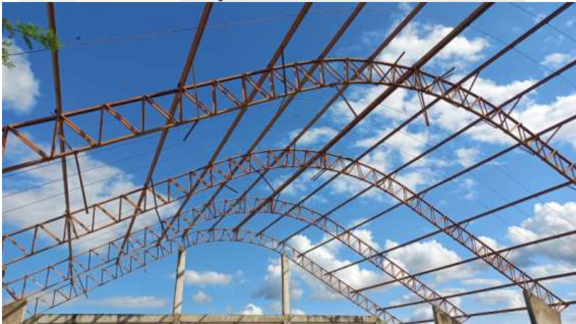
Figura 30 – Estrutura de coberta
