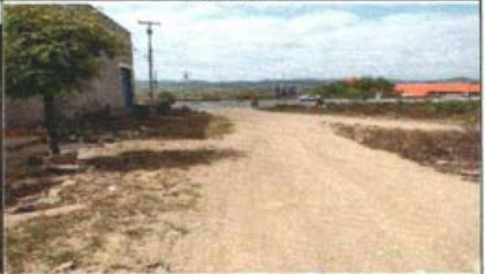
RUA SANTO ANTÔNIO
