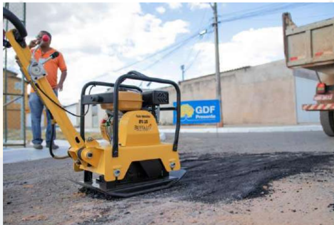
Figura 5 – Compactação da Massa Asfáltica
