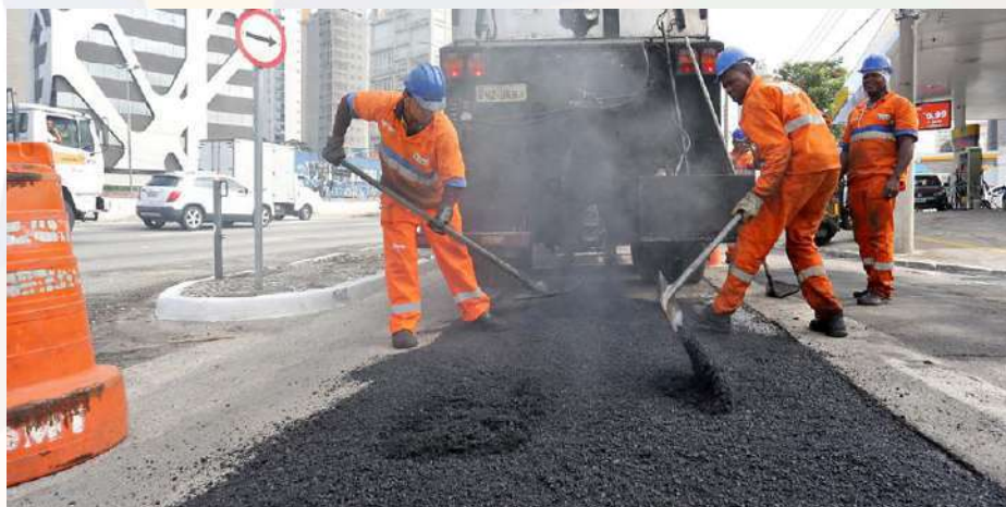
Figura 4 - Espalhamento da Massa Asfáltica
